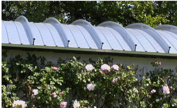
2002 nieuw dak garage van U-vormig gezette aluminium platen
