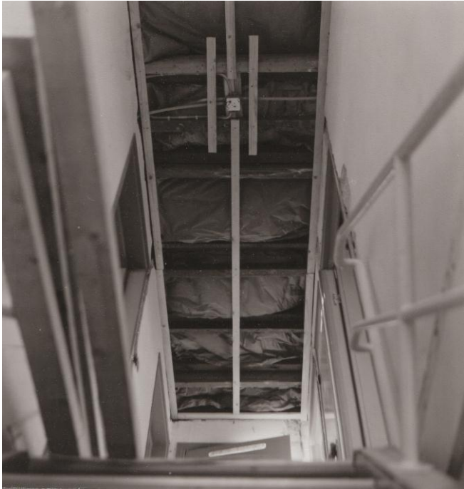
1980, boven alle plafonds worden steenwolplaten aangebracht
