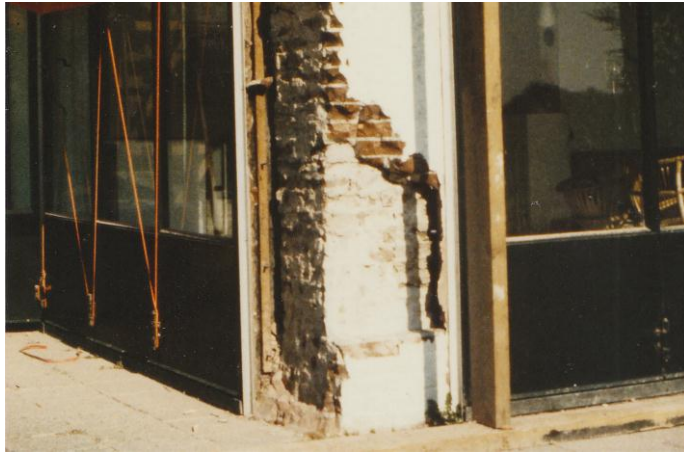
1987 het metselwerk van de hoekpenant is deels 10 cm afgehakt
