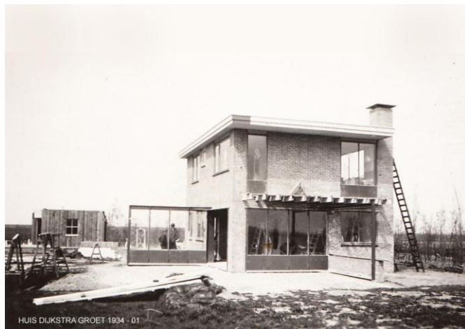
1934 - de bouw vordert
