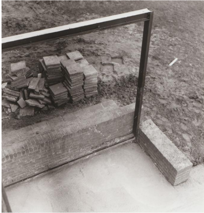
1981 betonvloer terras gereed voor terugleggen tegels, terrasmuur gestraald, nieuw laag muurtje van niet geglazuurde steen.
