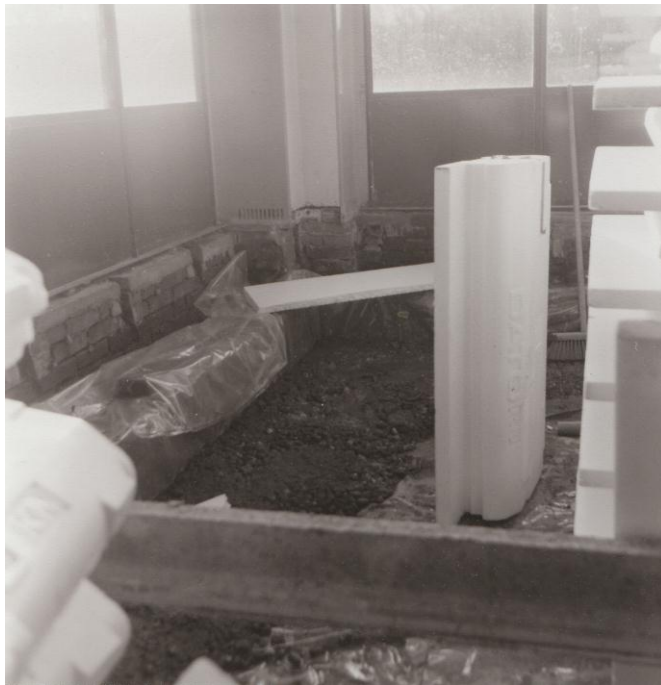
Woonkamer: houten vloer gesloopt, eerste prefab balk aangebracht Rechtop staand: een van de piepschuim bekistingselementen.
