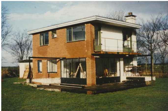
1987 het nieuwe buitenspouwblad van de ZW-gevel is opgetrokken
