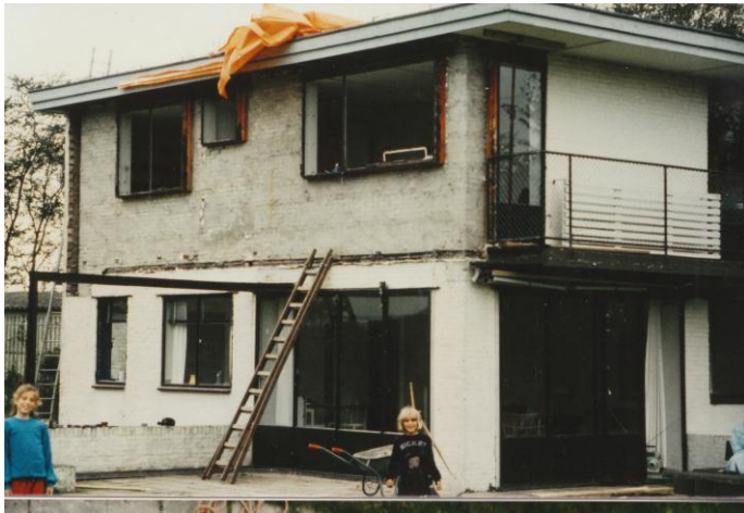
1987 het spouwblad op de verdieping is gesloopt. De ramen zijn alweer teruggeplaatst.
