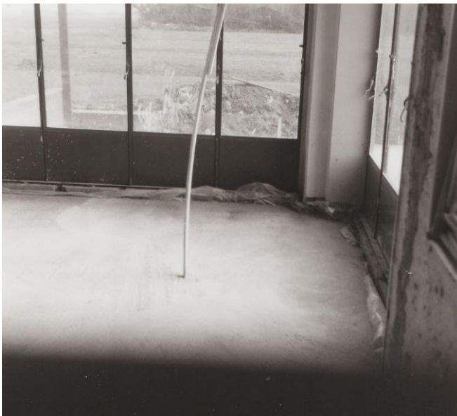
1981, de woonkamervloer is gereed voor betegeling.
