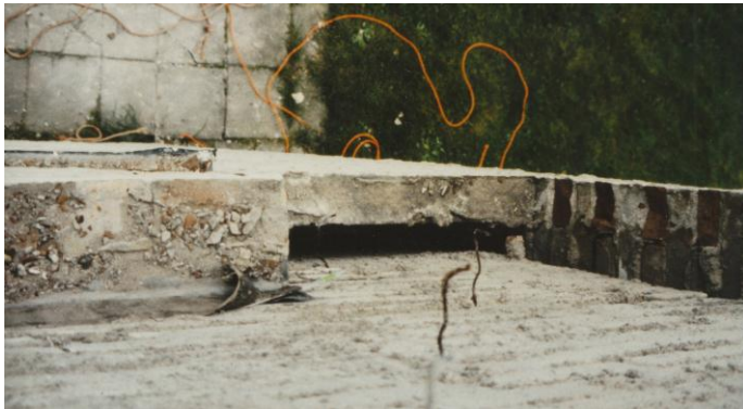
1987 idem het deel bij de keuken op de begane grond. Het massieve deel van de muur op de begane grond is goed te zien.
