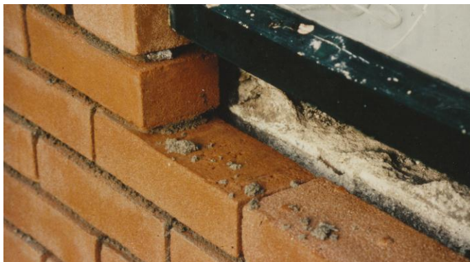
1987 bovenaanzicht 7 cm gezaagde steen en 3 cm spouw er achter
