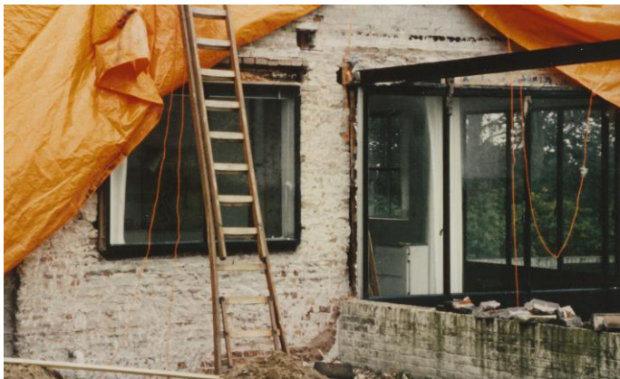
1987 op de begane grond is van het massieve metselwerk 10 cm afgehakt.
